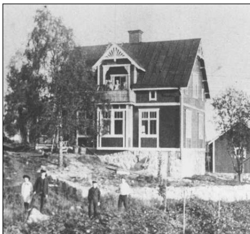
Bilden till vänster är huset sett från väster någon gång på 20-talet. Idag är huset vitt och bilden till höger är tagen mer från sydsidan.
