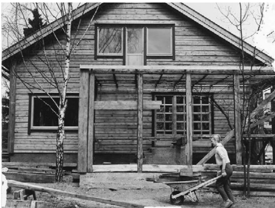
Huset från Marieberg har nästan helt byggts upp igen i Bromma Kyrka men det gamla brutna taket har ersatts av ett vanligt tak och de spröjsade fönstren har ersatts av moderna. Solveig Edrén sliter.
