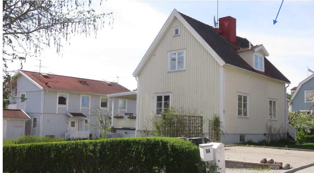
Vassvägen 9A och 9B (parhus byggt 1994) samt Vassvägen 9 (Maj 2016)
